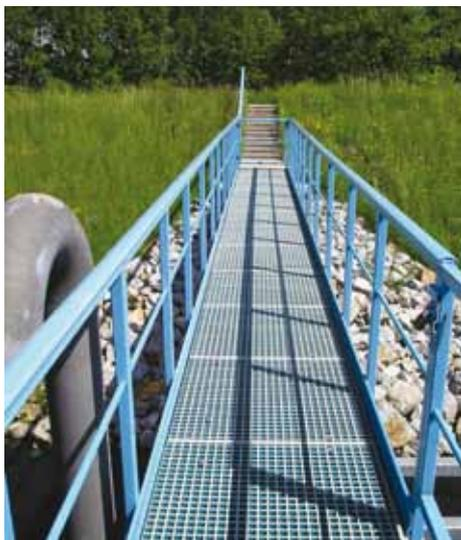
Gli elementi dei profili di parapetto sono realizzati con processo di pultrusione, (polimerizzazione a caldo di un profilo tirato in una filiera) e contengono fino al 70% di fibra di vetro che garantisce un'elevata caratteristica meccanica.
